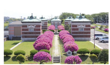
西谷浄水場濾過池整水室上屋3号棟
